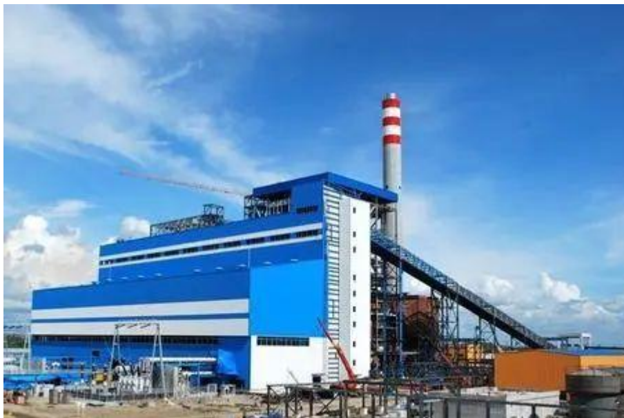
印尼火电站机组
