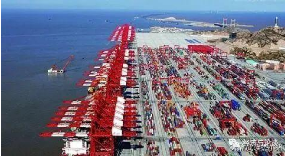
上海洋山深水港区工程
